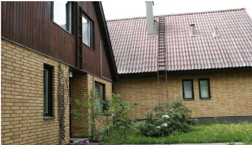
As Oy Säilätie 8, Länsimäki, Vantaa. 3 asunnon erillistaloyhtiö. Öljystä maalämpöön vuonna 2015. Aiempi öljynkulutus n.12000l / vuosi.
